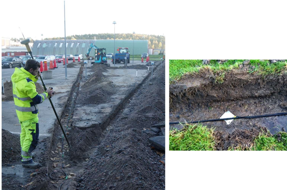
Figur 1. Installation av elektroder och elektrodkablar gjordes i grunda diken som fylldes igen så att parkering och gräsmatta kunde återställas. Alla elektroder och sensorer mättes in med differentiell GNSS.
